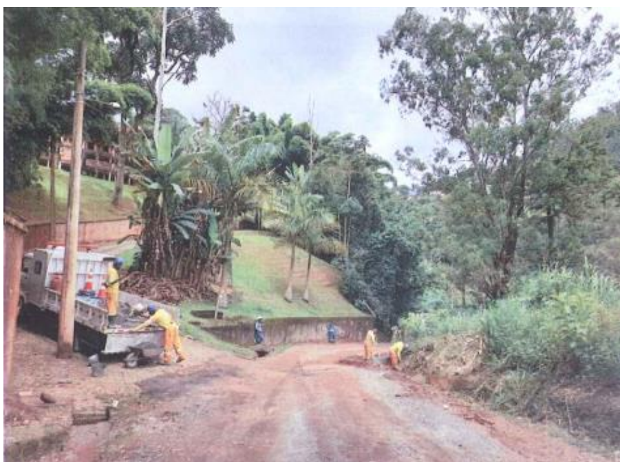
Foto 4 – Manutenção da Drenagem - Km 088+500
