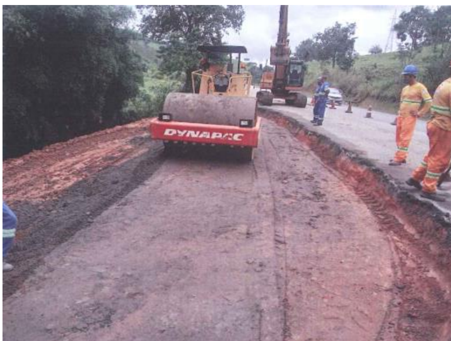
Foto 10 – Restruturação do Pavimento - Km 129+000 S [1]
