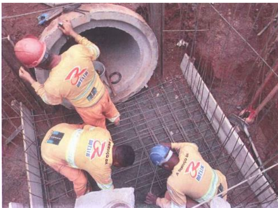
Foto 6 – Obra de Drenagem de Bueiro - Km 115+300 [2]
