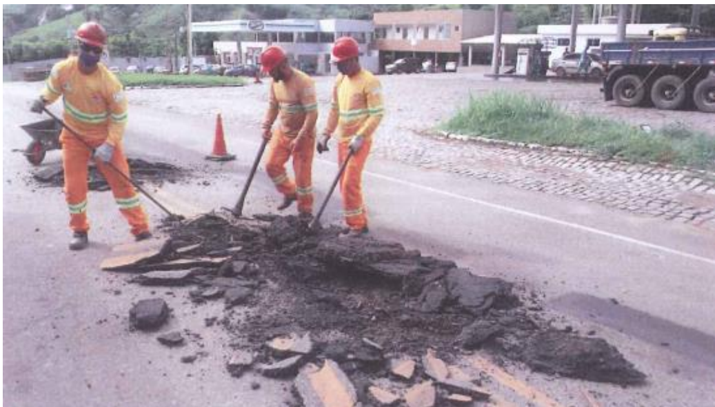
Foto 15 – Restruturação do Pavimento - Km 133+500 [1]
