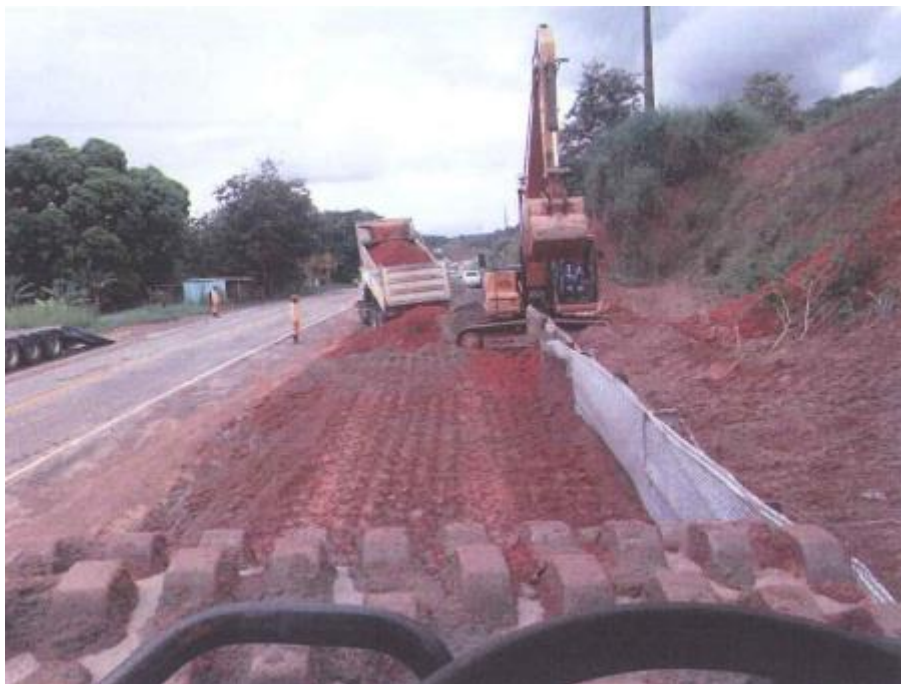
Foto 1 – Obra Emergencial de Contenção – Km 003+000 N
