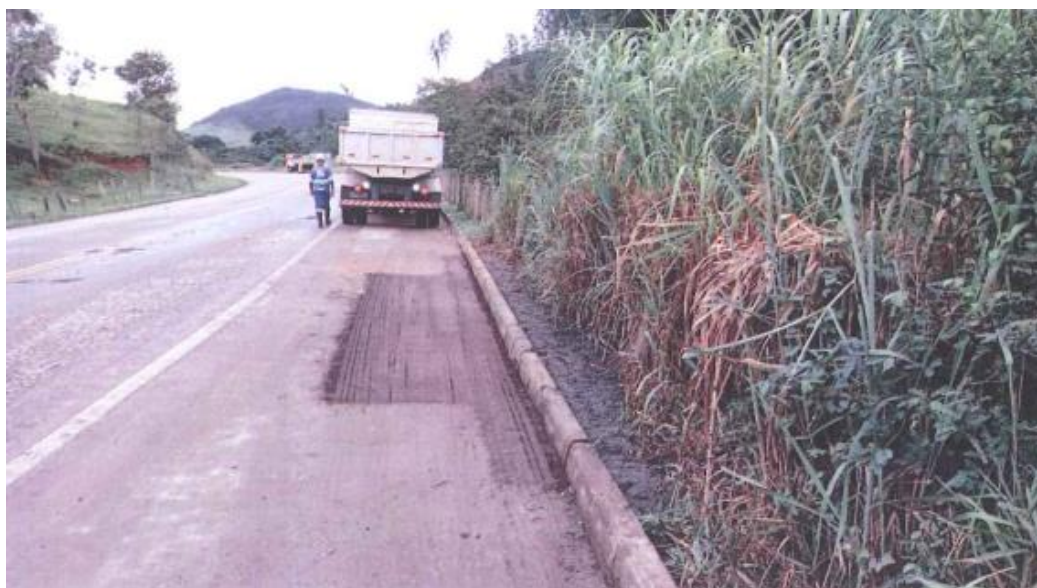
Foto 14 – Restruturação do Pavimento - Km 129+200
