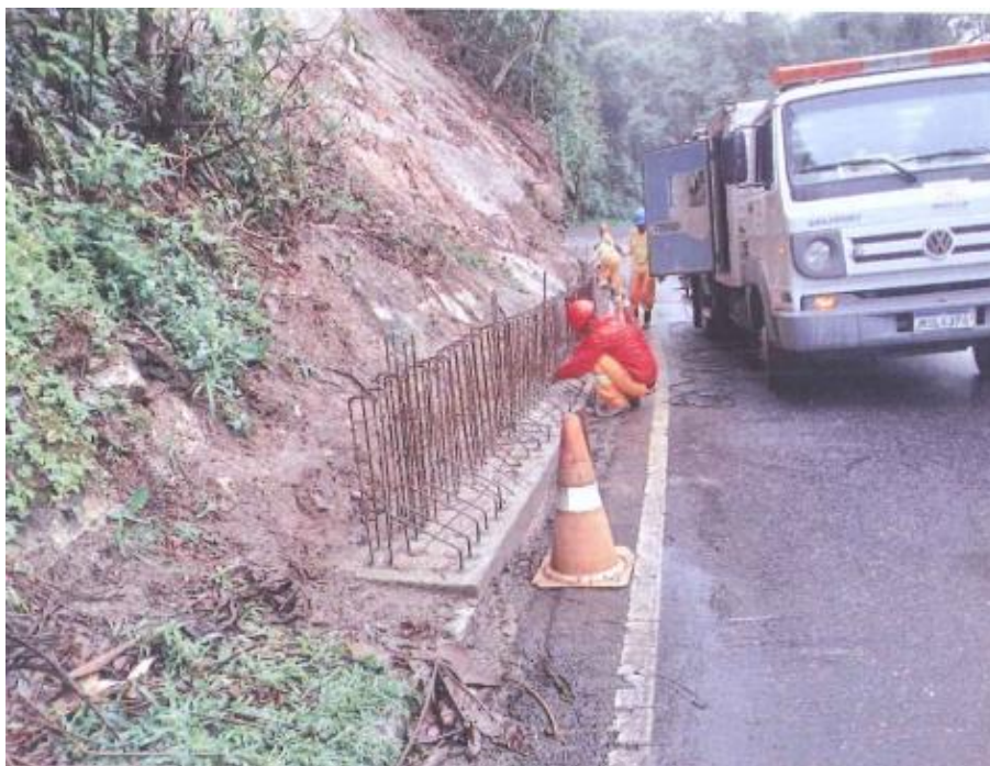
Foto 2 – Obra Emergencial de Contenção - Km 051+900 N
