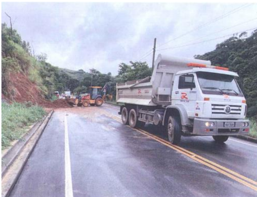
Foto 7 – Queda de barreira - Km 132+600 S
