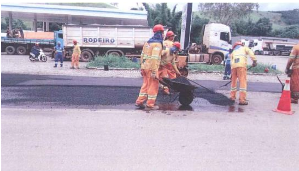
Foto 16 – Restruturação do Pavimento - Km 133+500 [2]
