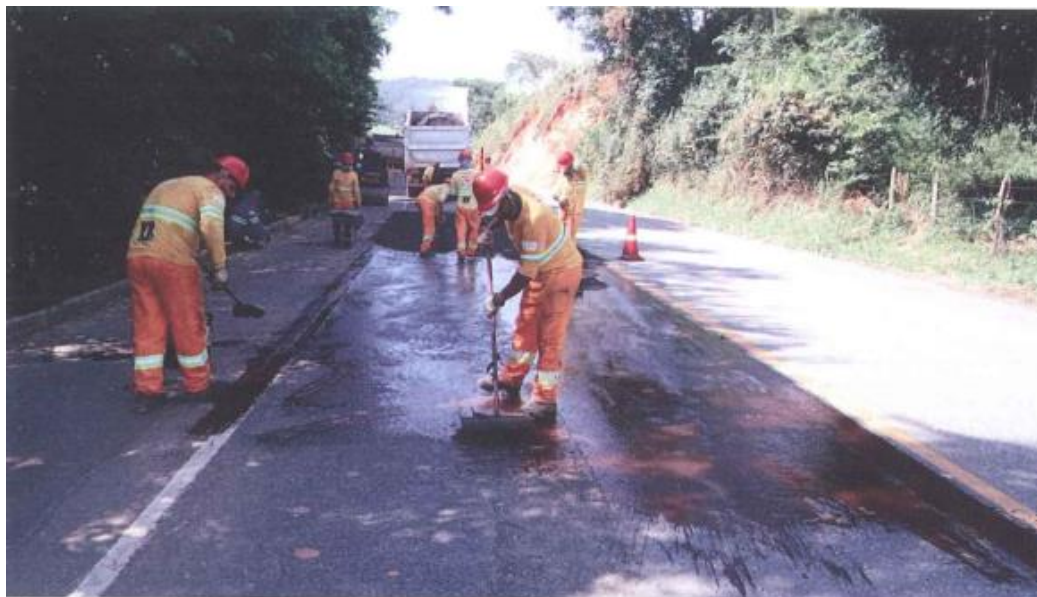
Foto 13 – Restruturação do Pavimento - Km 127+000
