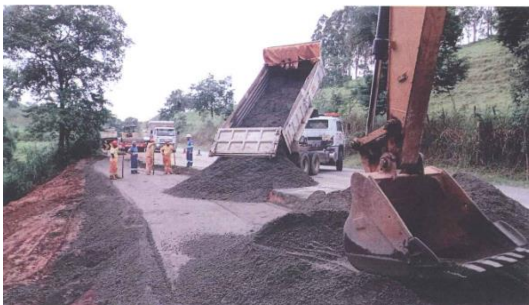
Foto 12 – Restruturação do Pavimento - Km 128+700 S
