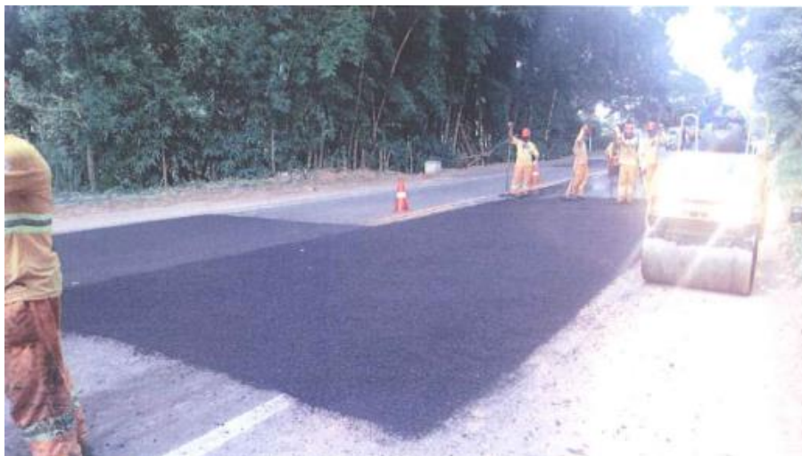
Foto 9 – Reparos na Pavimentação - Km 128+200
