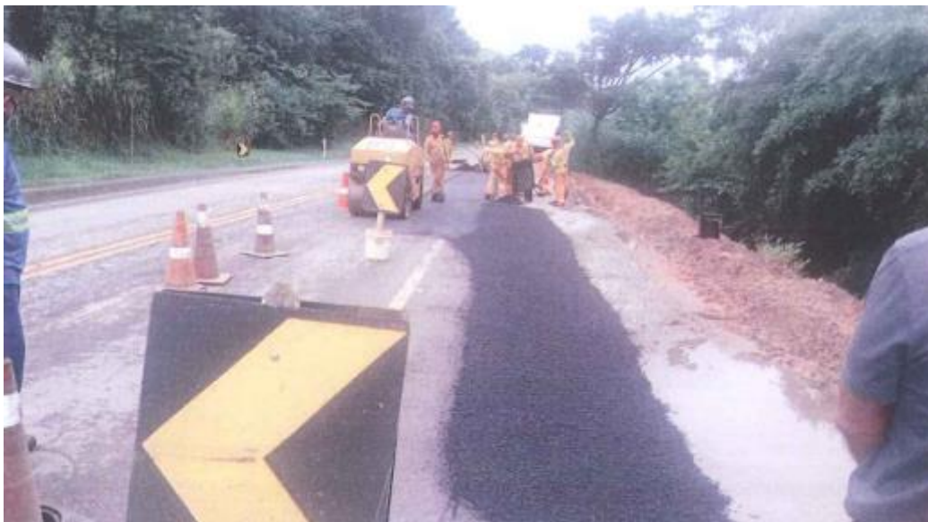
Foto 11 – Restruturação do Pavimento - Km 129+000 S [2]
