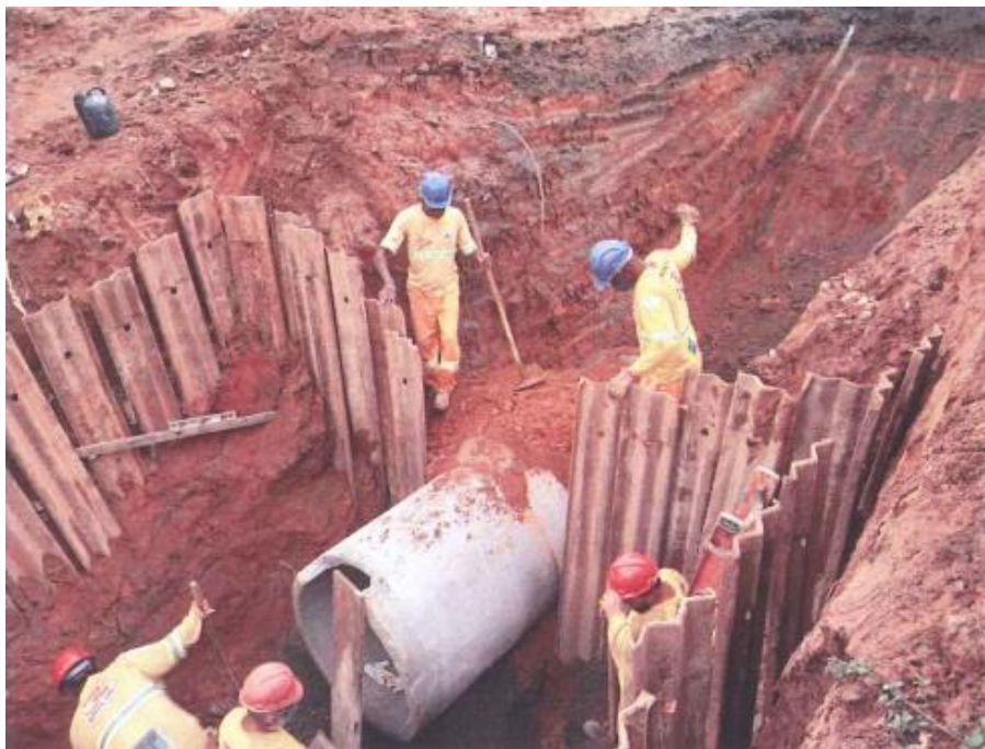
Foto 5 – Obra de Drenagem de Bueiro - Km 115+300 [1]
